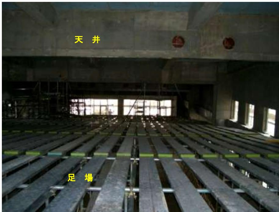
開架室の天井付近の工事(空調設備機器を天井から吊り込む工事, 電気ケーブルを配線する工事などがあります)を行うため, 内部の足場が組み直されています。
