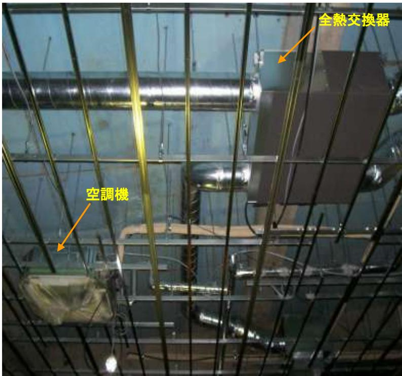
全熱交換器は、外から取り入れる空気と室内から排出する空気を入れ替える際に、外気を室内の温度・湿度に近づけるために、排出する室内の空気と外気の間で温度・湿度を交換する設備です。
