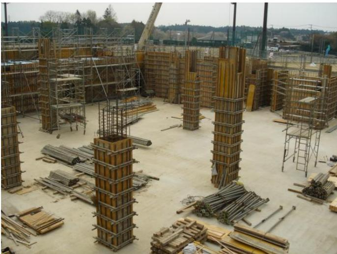
仮設工事，型枠工事を行っています。
