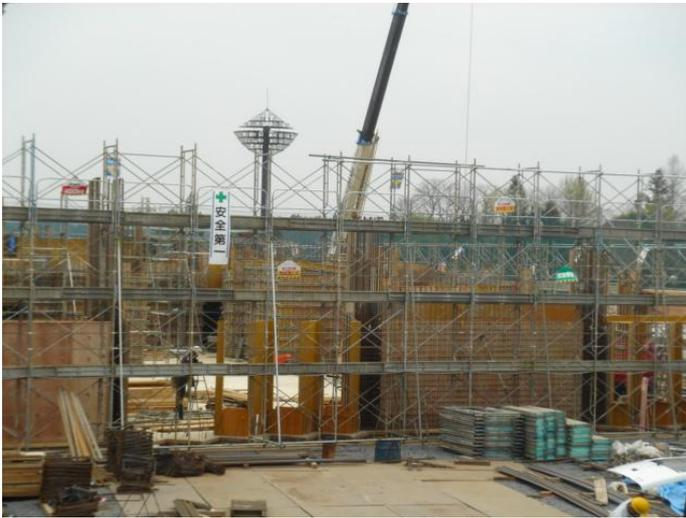
開架室の壁を作るための型枠工事を行っています。
